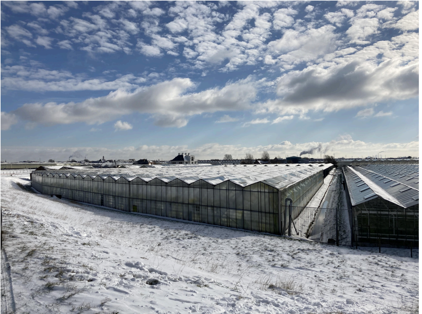
In Nederland bracht het gewicht van het sneeuw schade teweeg bij de serres
