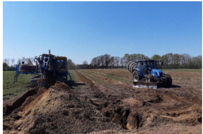
Aanleg van het subirrigatiesysteem, bestaande uit infiltrerende buizen
