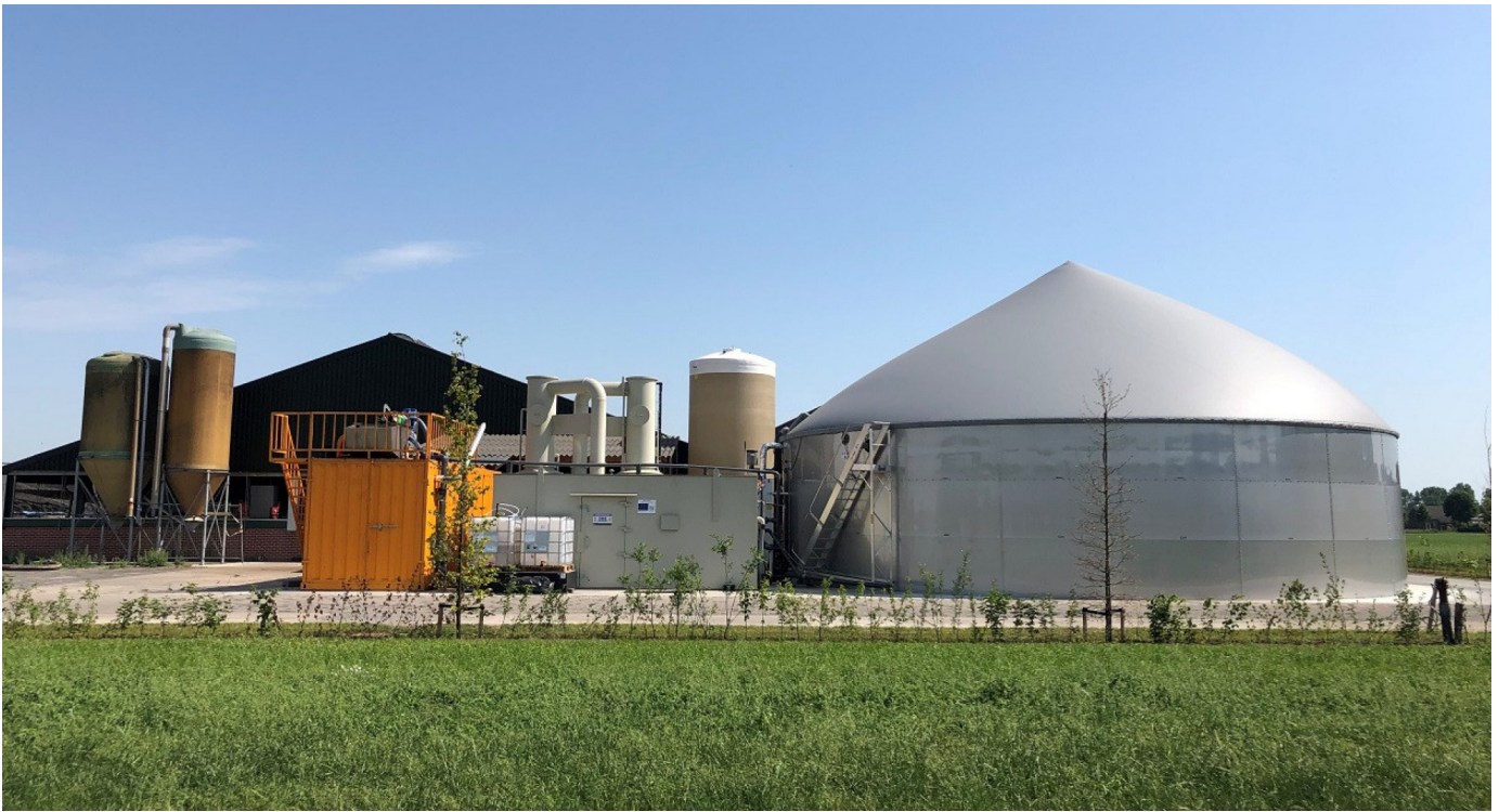
Een 44kW pocketvergister met dik/dunseparator en stikstofstripper op het melkveebedrijf Voet in Schaijk, Nederland
