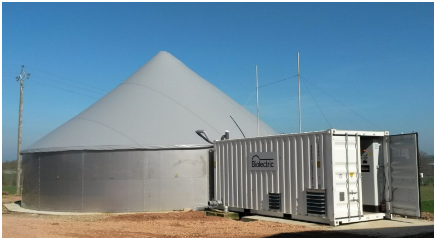
Een 44kW pocketvergister op een melkveebedrijf in Frankrijk
