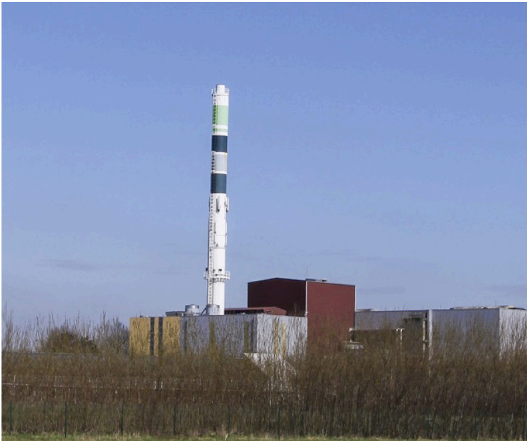
MIROM verbrandingsoven is zichtbaar vanaf het glastuinbouwbedrijf van Tuur Galle in Roeselare
