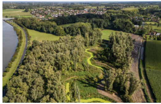
Dronebeeld van het afgeronde project. Foto: VMM
